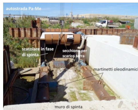
Fig. 3 Martinetti e muro di spinta
